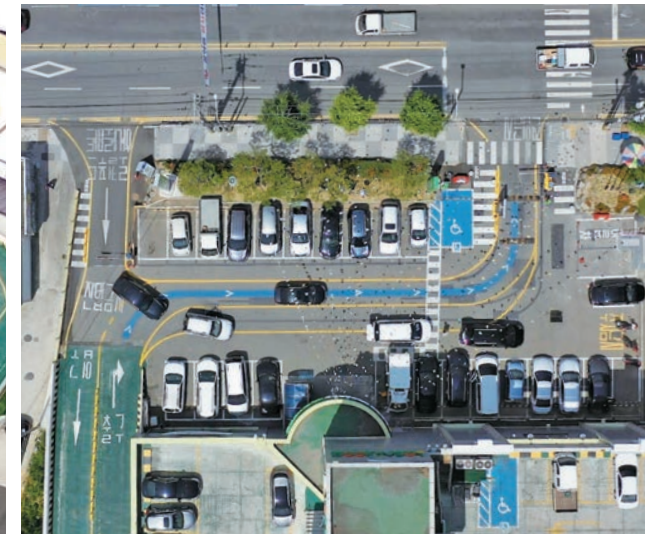
주차장 공사 전(왼쪽 사진)과 공사 후의 모습
